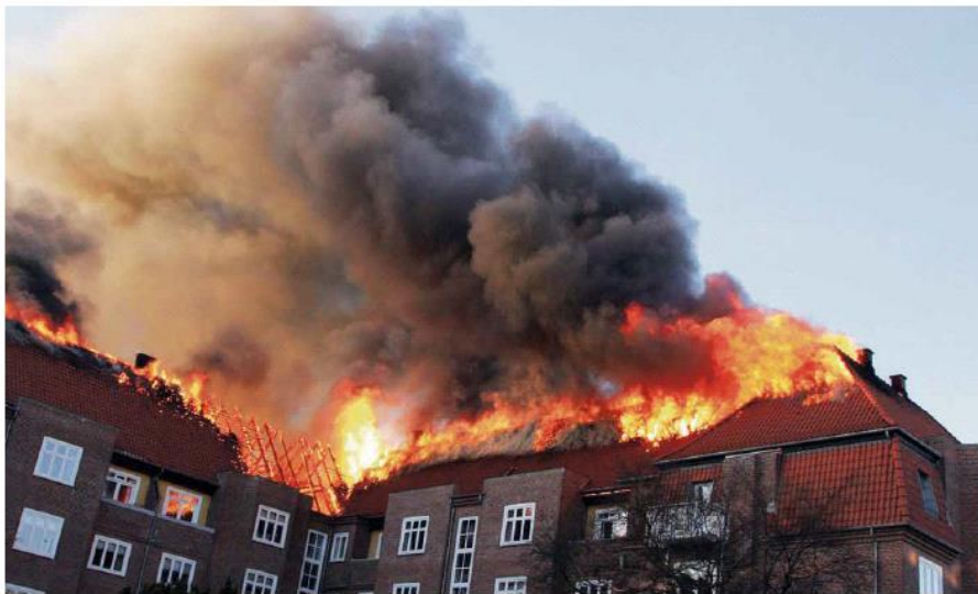
DE STORE BRANDE forekommer ofte i gamle etageejendomme, hvor der er store spidstagede tagrum med masser af brandbart materiale i putterum og masser af luft til at nære branden. Foto: Københavns Brandvæsen
